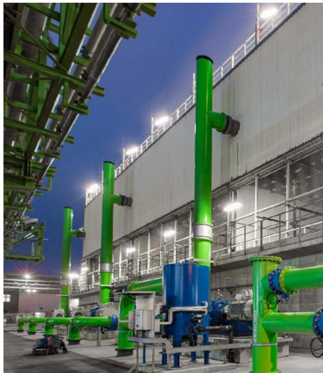
Wesseling: Erwärmtes Kühlwasser wird in der Rückkühlanlage, die aus glasfaserverstärktem Kunststoff besteht, heruntergekühlt und zum Teil wieder in den Kühlkreislauf zurückgeführt.
