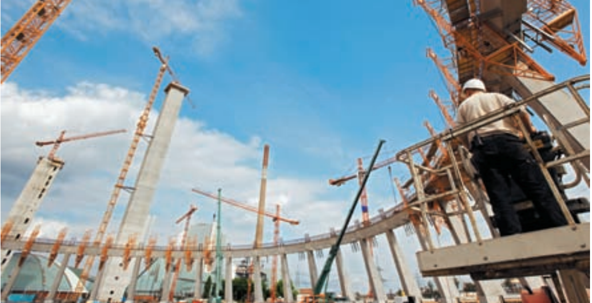
Ideen mit mehr Wirkungsgrad: In Duisburg-Walsum entsteht ein Steinkohlekraftwerk mit 750 Megawatt Leistung. Bisher unerreicht: der Nettowirkungsgrad von mehr als 45 Prozent. Er liegt über fünf Prozent höher als die bisher besten Werte bestehender deutscher Kraftwerke zur Steinkohleverstromung. Damit ist Evonik führend bei modernen Technologien zur Steinkohleverstromung.
